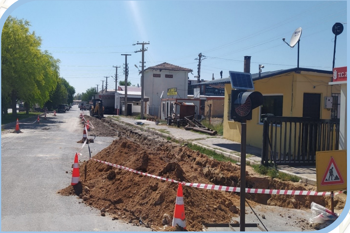
Duktil Boru Çalışmaları
